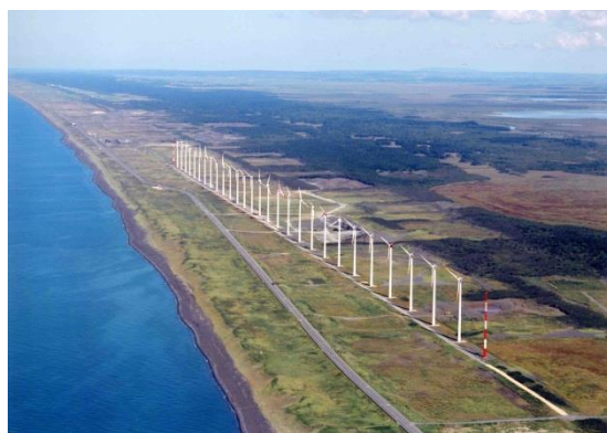
図2：発電用風車の設置例
